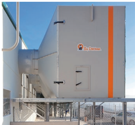
Установка на центральную систему подачи приточного воздуха
